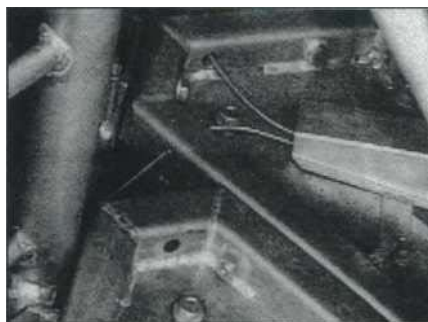
Image d'une structure métallique par 2200m de fond, transmise par ondes acoustiques.
