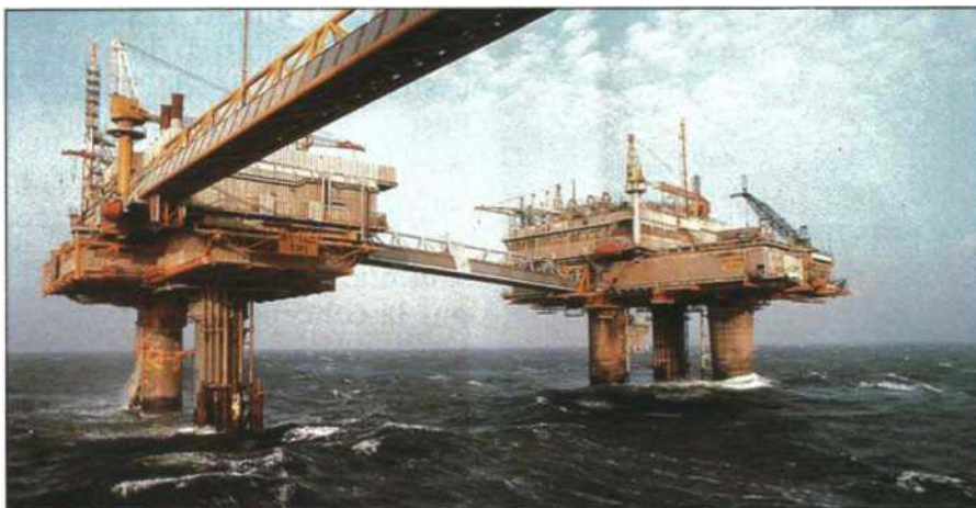
Un exemple d'application industrielle de la surveillance des vibrations in situ ; la maintenance des plates-formes offshore. Ici, le champ de F rig en mer du Nord. (Doc Elf Aquitaine).
